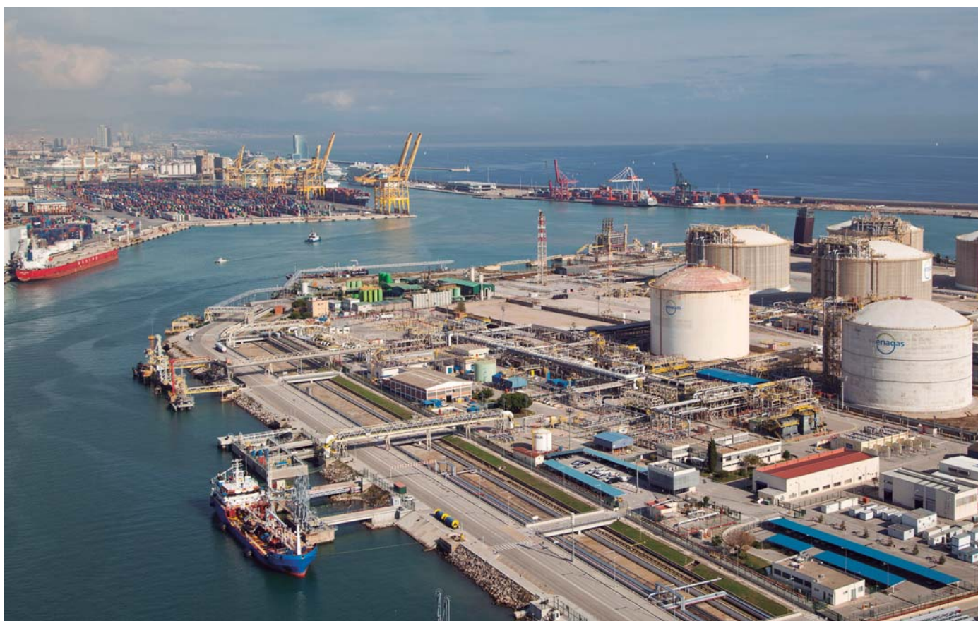
Vista aérea de las terminales de graneles líquidos y contenedores del Puerto de Barcelona.
