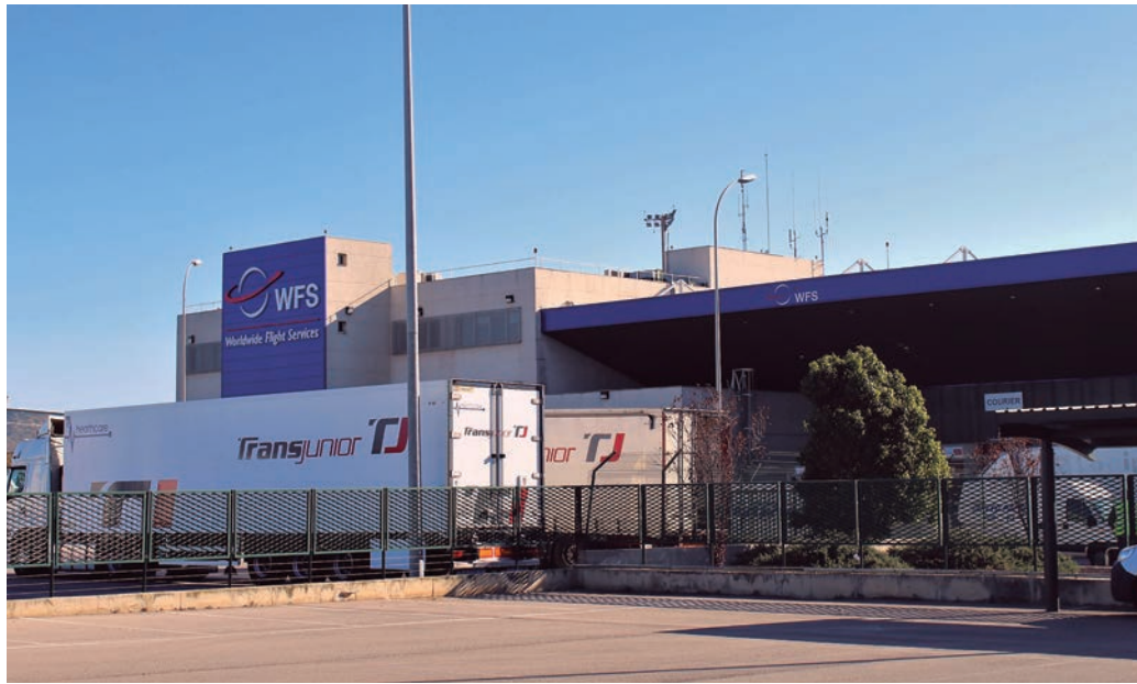
Centro de carga aérea del Aeropuerto de Barcelona-El Prat. Foto JMR.
